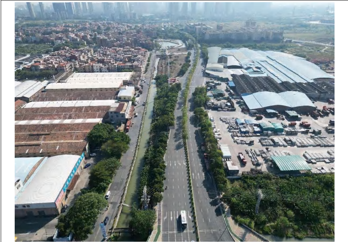
项目建成图—科润路
